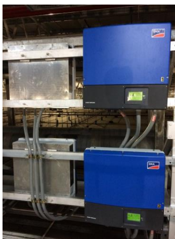
ภาพที่ 3 การติดตั้ง อินเวอร์เตอร์
