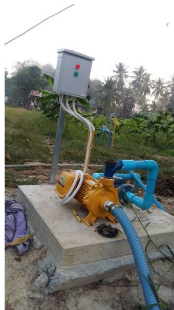
ภาพที่ 5 การวางปั้มน้ำและอุปกรณ์ส่งสัญญาณบนเครือข่ายไร้สาย เพื่อจ่ายน้ำในสวนกล้วยหอมทอง
