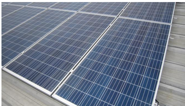
ภาพที่ 2 การวางแผงโซลาร์เซลล์บนหลังคา
