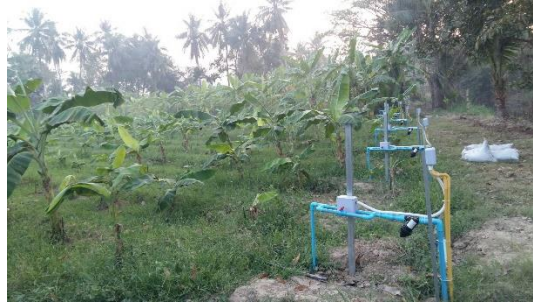
ภาพที่ 4 วาล์วน้ำ และการวางท่อจ่ายน้ำตามร่องในสวนกล้วยหอมทอง
